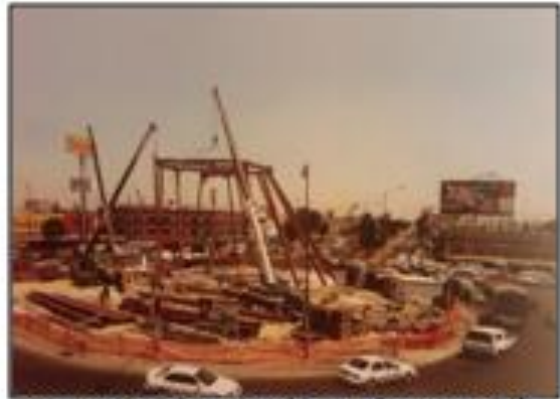
Construcción de la escultura "El Coyote" entre Av. Adolfo López Mateos y Av. Panófilo.
