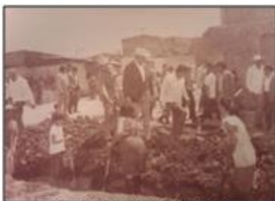
Trabajo en las obras de agua municipal. (Biblioteca Municipal)
